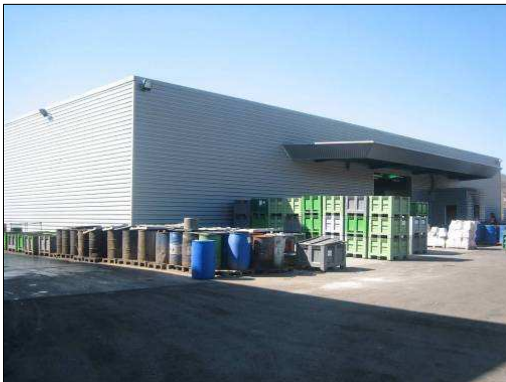
Façade Est du bâtiment produits dangereux
