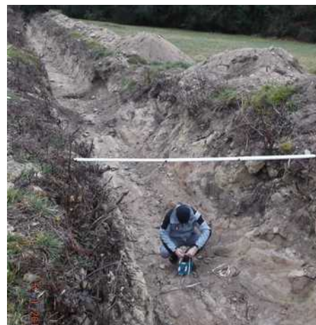
Curage d'un ruisseau
