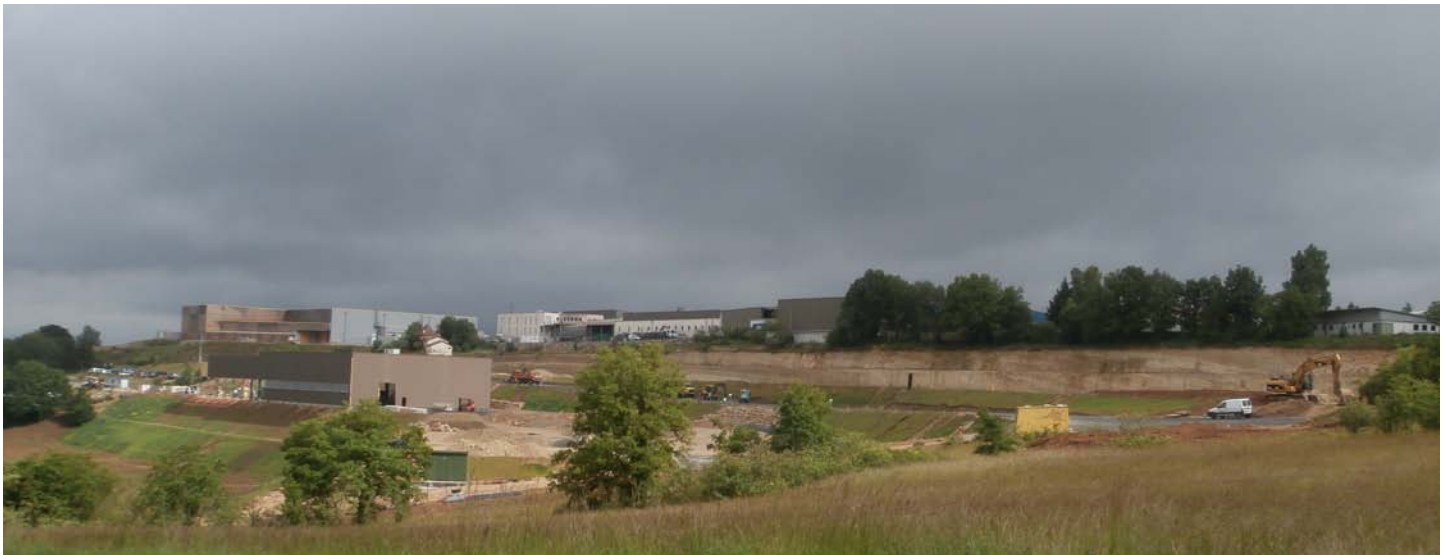
Extension de la zone industrielle de l'Aiguille à Figeac pour le développement de Figeac'Aéro
