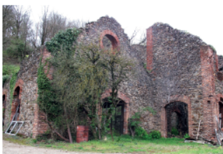
Vestiges de la laverie de Bouillac
