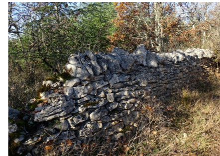
Réseau de murets en pierres sèches
