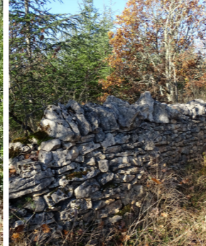
Muret pierre sèche
