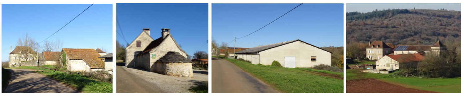
URBANISATION : un causse quasiment inhabité hormis quelques fermes isolées, hangars agricoles et hameaux en bordure de routes ou de parcelles de cultures. Un réseau de murets et un petit patrimoine en pierre sèche qui tendent à disparaître sous la végétation.
