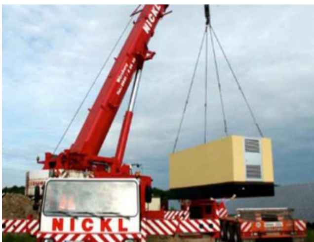
Pose d'un poste de livraison
