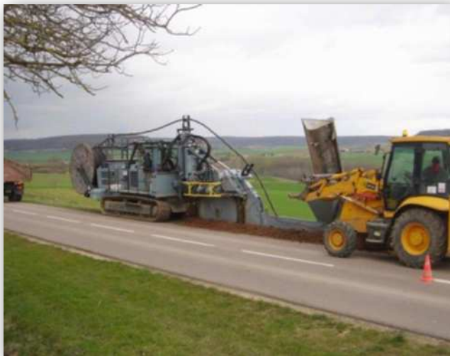
Pose du câble de raccordement
