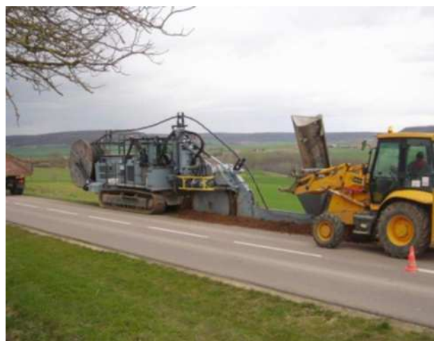
Pose d'un câble de raccordement
