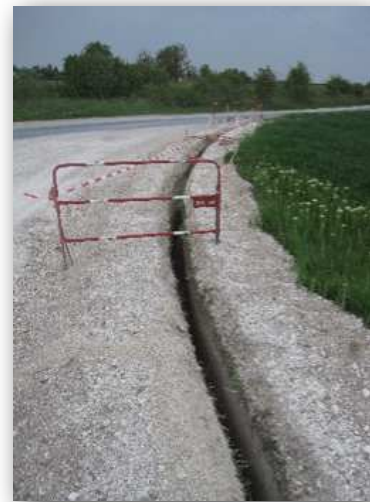
Exemple de tranchée réalisée
