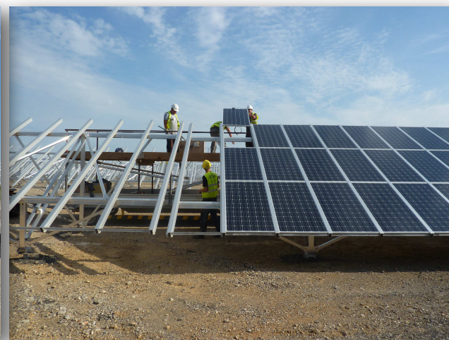
Pose des panneaux photovoltaïques
