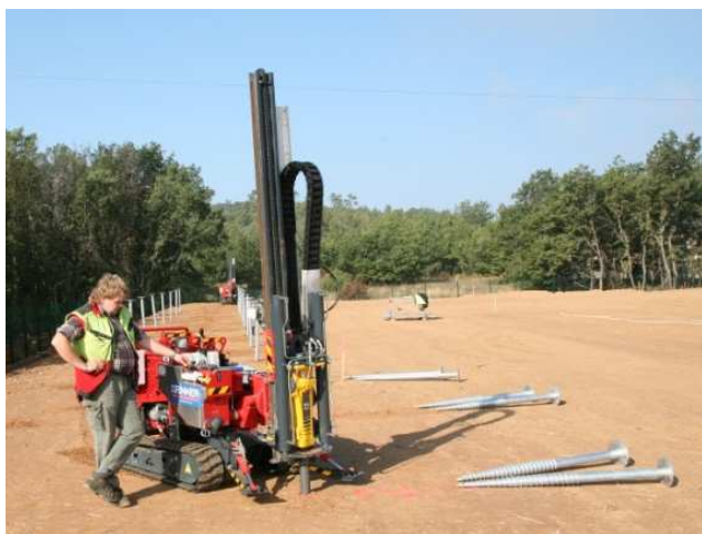
Fixation des pieux vissés
