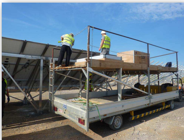
Pose des panneaux photovoltaïques
