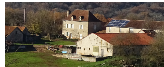
Panneaux photovoltaïques sur toiture à l'Espinasse (Nougayrac)
