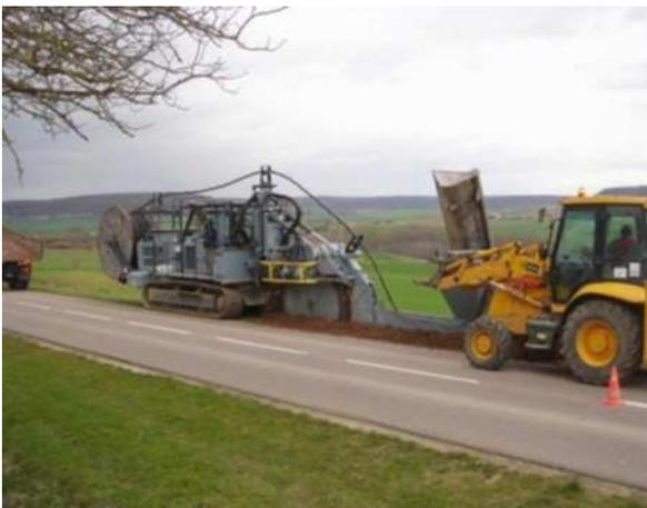
*Illustration des travaux d'enfouissement d'un câble de raccordement le long de la voirie*
