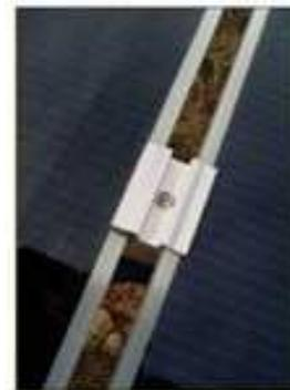
*Illustration des espaces entre modules permettant l'écoulement des eaux de ruissellement*
