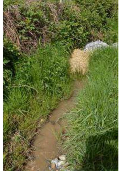
Exemple d'intervention avec installation d'un filtre à paille
