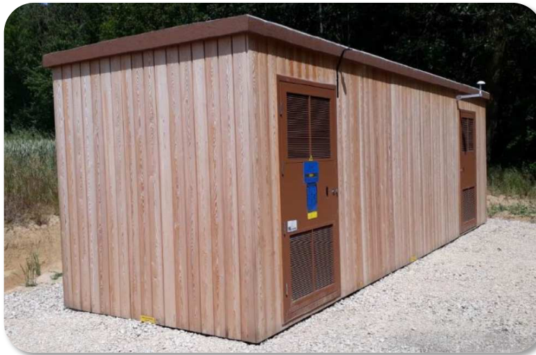
Photo 9 : Exemple de poste de livraison
