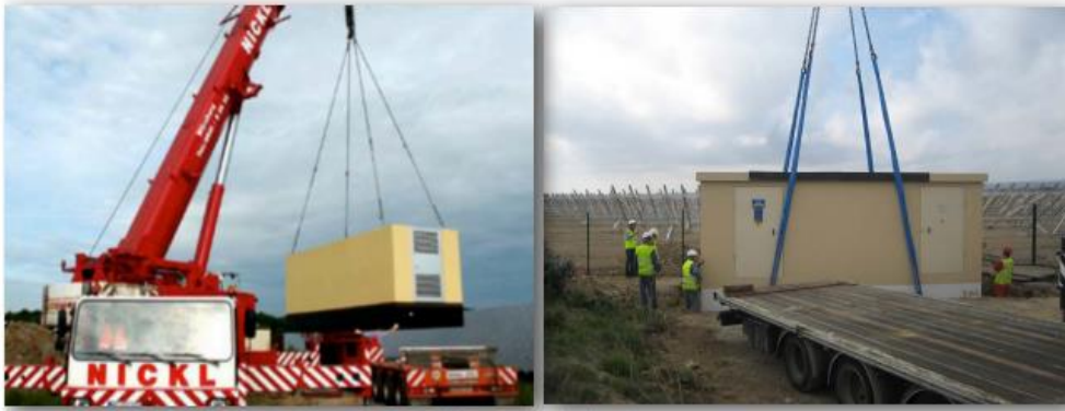
Pose d'un poste de livraison
