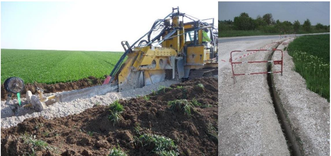
Figure : Exemple de tranchée réalisée (Source : TotalEnergies)
