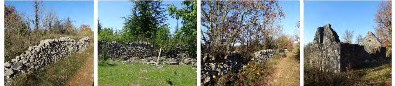
Maintien des ruines, chemins et murets existants
