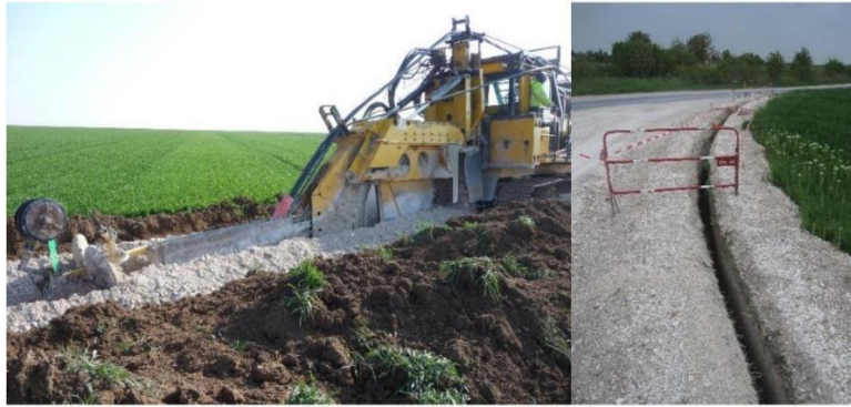
Figure : Exemple de tranchée réalisée (Source : TotalEnergies)
